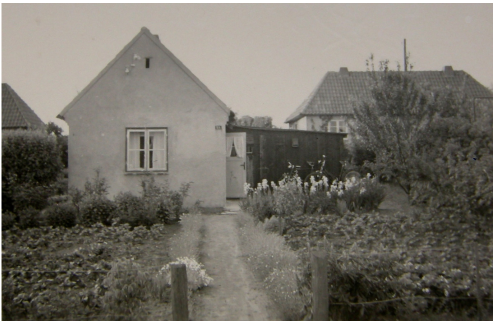
Behelfsheim Nr. 15 von Süden 1952, rechts hinten Doppelbehelfsheim Nr.3a/b, links Walmdach von 2b
