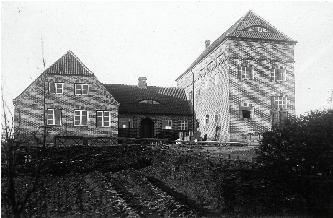
Abb.1: Aufnahme J. Garleff: Schaltheus Anfang März 1923. Bild Landesamt für Denkmalpflege Schleswig-Holstein
