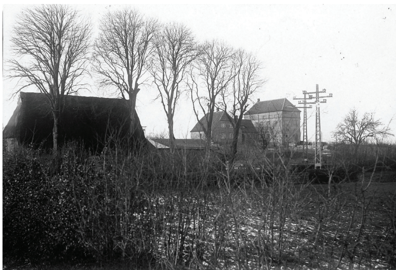
Abb.2: .Aufnahme J. Garleff: Schalthaus Anfang März 1923. Bild Landesamt für Denkmalpflege Schleswig-Holstein
