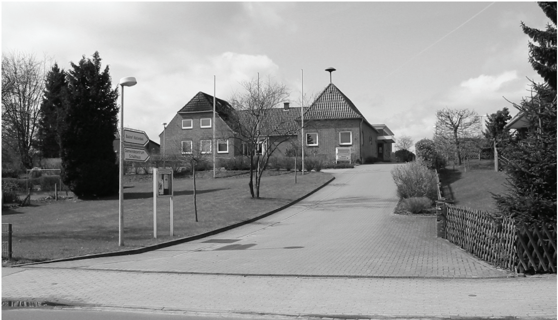
Abb.7: Schaltheus im April 2006, Ostansicht
