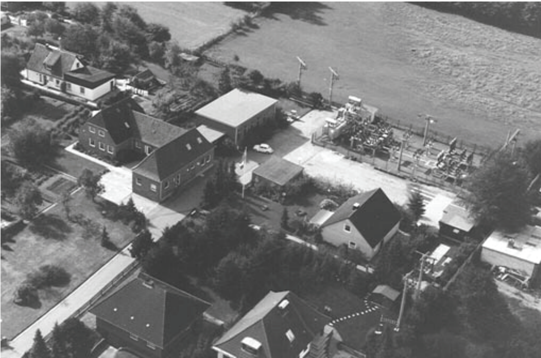
Abb. 15: 60-KV-Freiluftanlage, Foto Ingo Hamann, Sept. 1983, bei einem Hubschrauber-Kontrollflug
