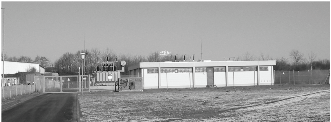
Abb. 26: Das heutige UMSpannwerk WATTENBEK liegt in Nienröden an der L 49, knapp 400 m nördlich vom alten Schaltheus.
