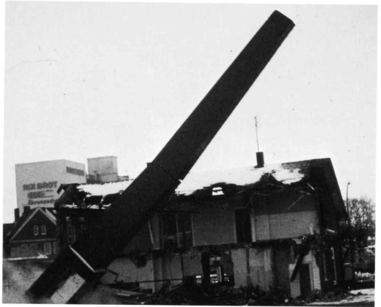
Abbruch der Meierei, das Wahrzeichen fällt 1977
