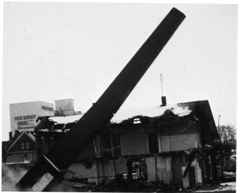
Abbruch der Meierei, das Wahrzeichen fällt 1977
