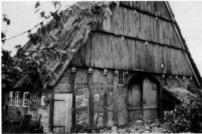
Alte Räucherkate vor der Restauration
