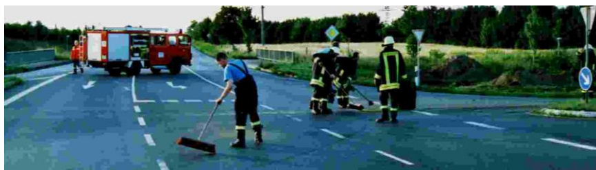
Fahrbahnreinigung auf der Kreisstraße 8
