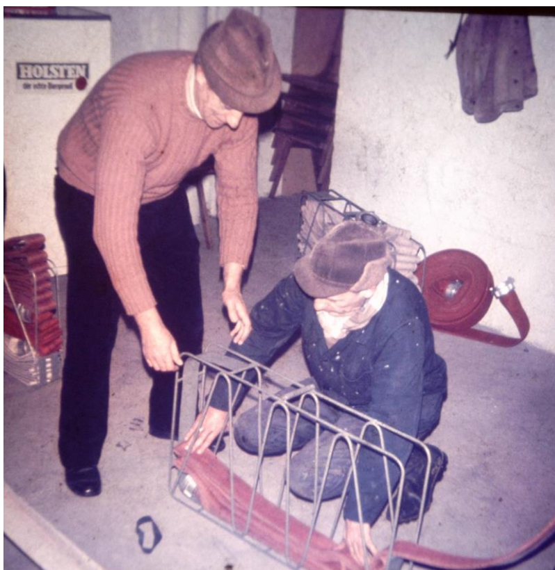
Bestücken der neuen Schlauchkörbe
