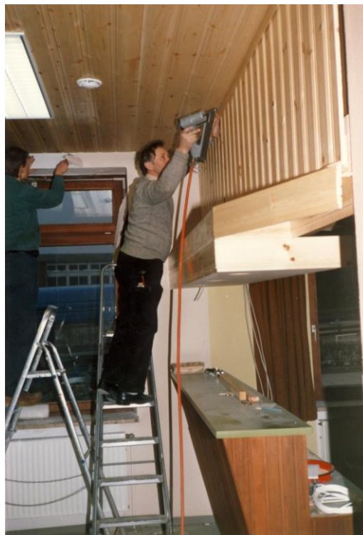
Renovierung des Feuerwehrgerätehauses
