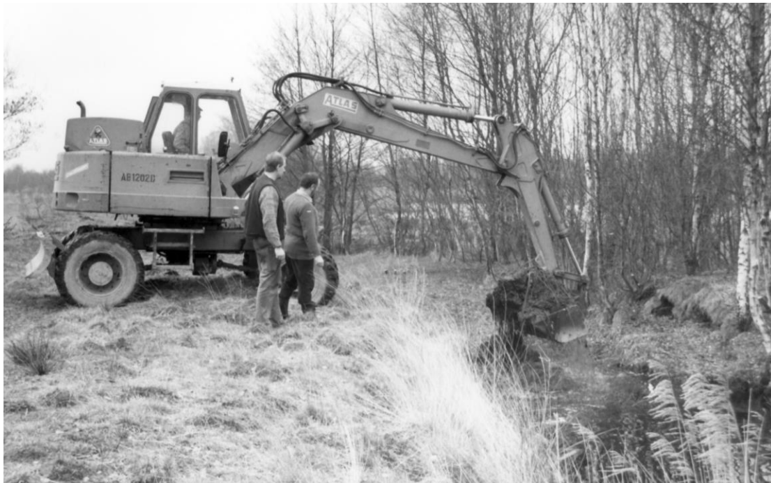
Baggerarbeiten im Dosenmoor
