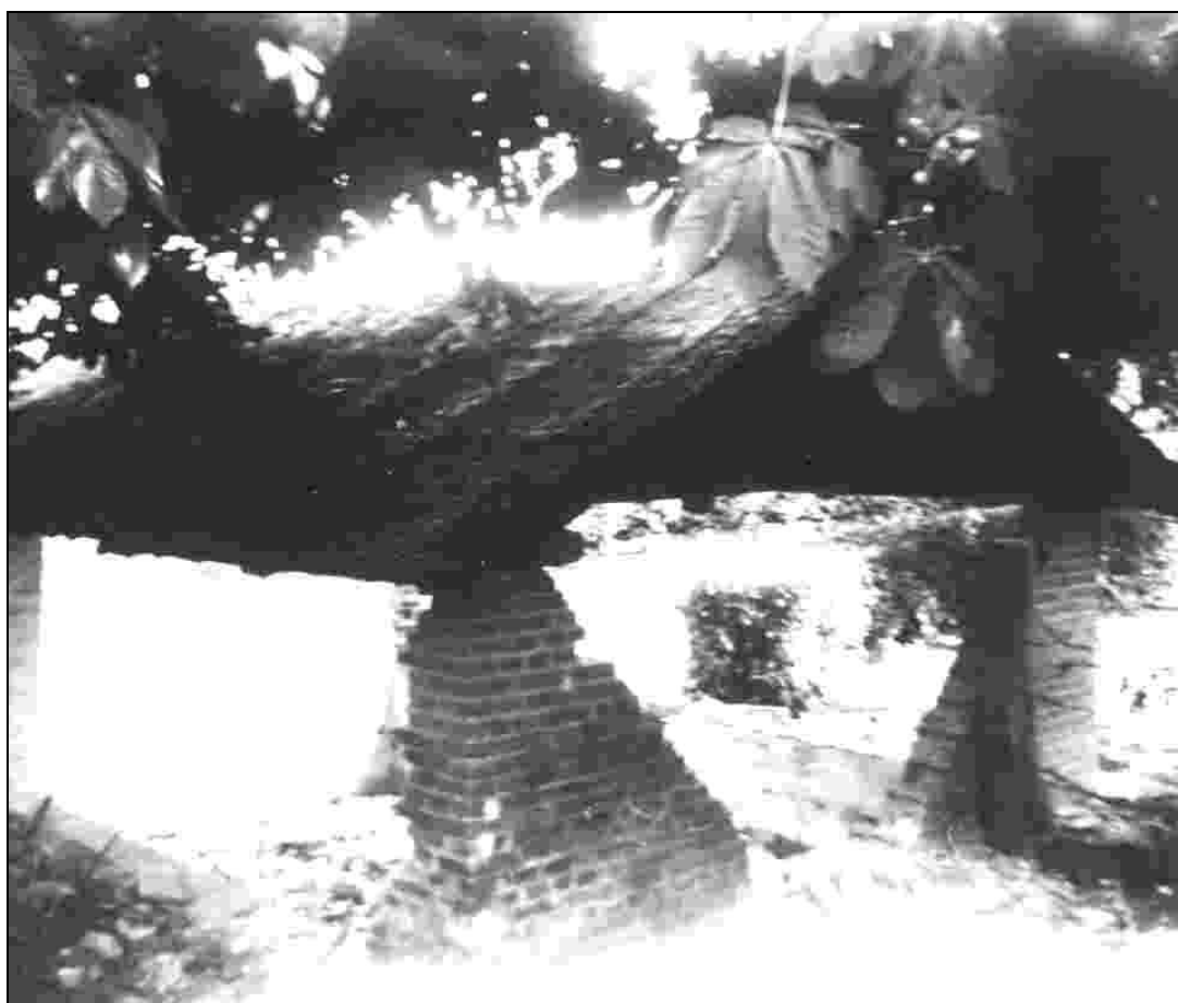
Abriss Spritzenhaus, Ruine
