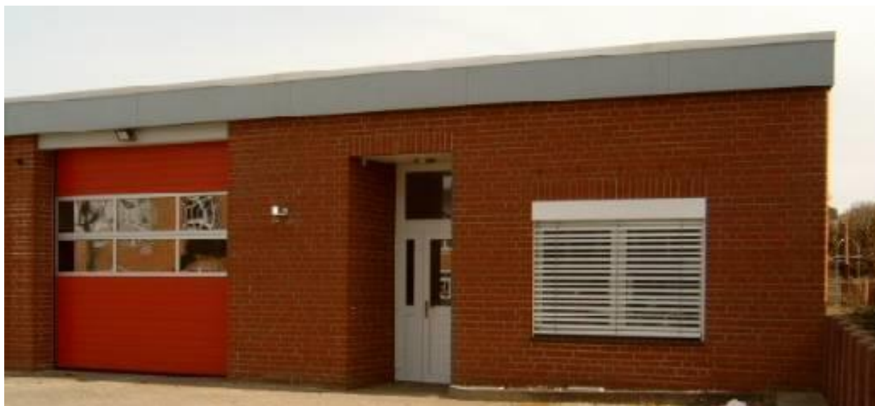
Anbau ans Feuerwehrhaus
