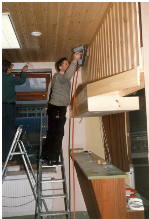
Renovierung des Feuerwehrgerätehauses
