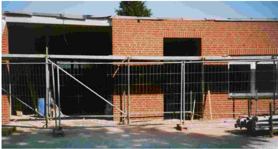
Fortgang der Arbeiten
