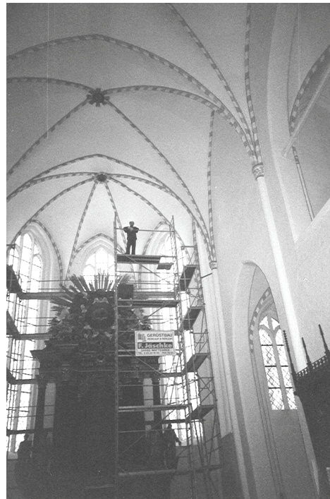
Oben: Gerüst in der Klosterkirche Bordesholm
