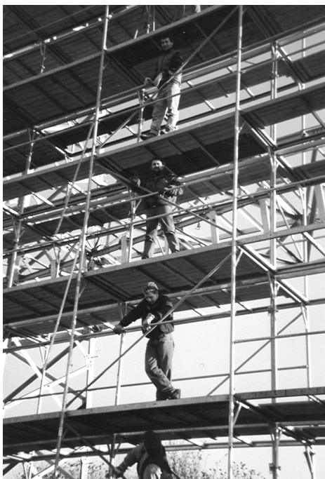
Links und unten: Gerüst für das Anbringen der Isolatoren am Abspannmast neben der L 49 in Wattenbek
