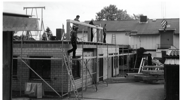
1995-97 wurde die Werkstatt aufgestockt
