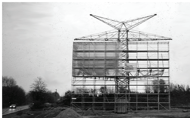
Links und unten: Gerüst für das Anbringen der Isolatoren am Abspannmast neben der L 49 in Wattenbek
