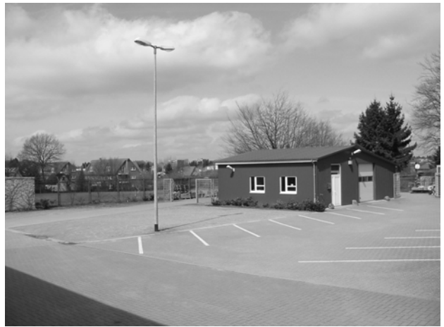
Bauhof der Gemeinde am Schaltheus
