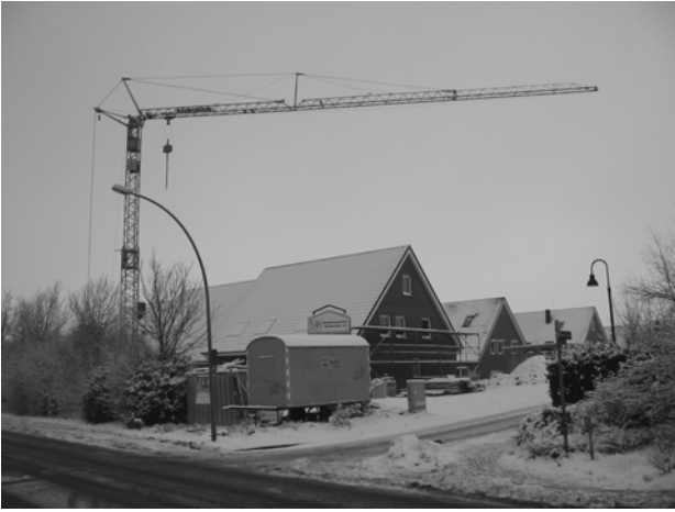
Einfahrt Jakob-Hinrichs-Weg, links letzter Bauabschnitt
