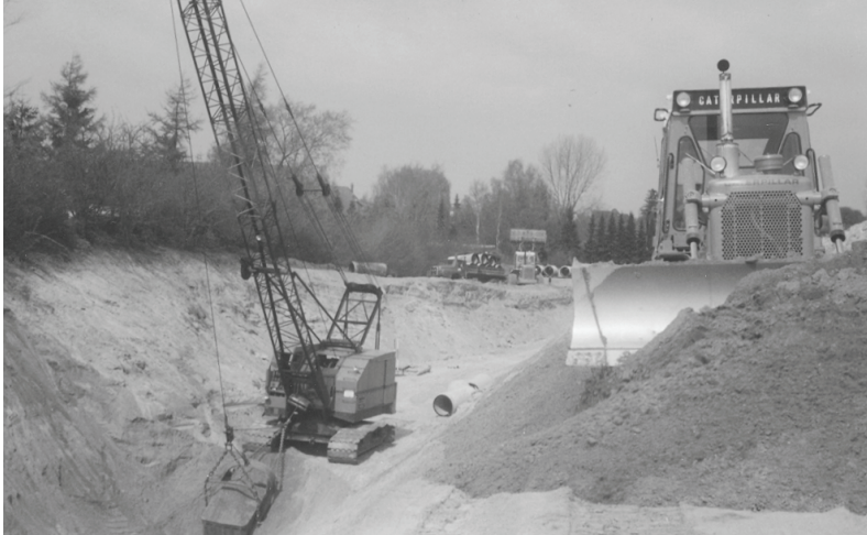
Die Leitungen wurden ca. 9 m tief im „Tagebau“ verlegt. Jetzige Rosenstraße Aufnahme April 1981
