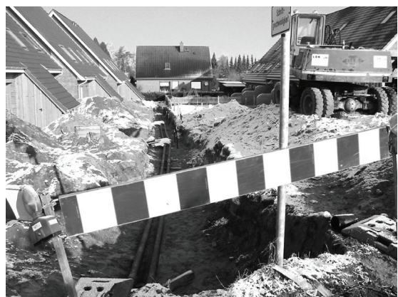
Rohre der Fernheizung zwischen den Häuserreihen Jakob-Hinrichs-Weg 2 und 4 am 29.3.06
