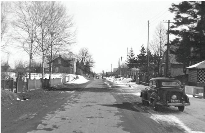
Brügger Chaussee Aufnahme ca. 1950/1952 Teerstraße mit Sandstreifen, rechts Brügger Chaussee 11
