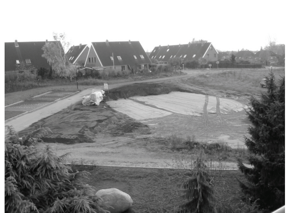
Baubeginn Jakob-Hinrichs-Weg 6a-e am 7.11.04
