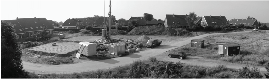
Das Baugebiet „Saalskamp“ wurde 2006 abgeschlossen. Baubeginn der Häuser Jakob-Hinrichs-Weg 1-9 war 2002, im Hintergrund Häuser vom Neuen Kamp, Aufnahme 31.7.02
