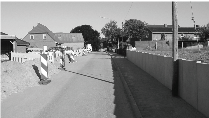
Westliches Ende der Baustelle vor der Dorfstraße mit abgestützter Böschung
