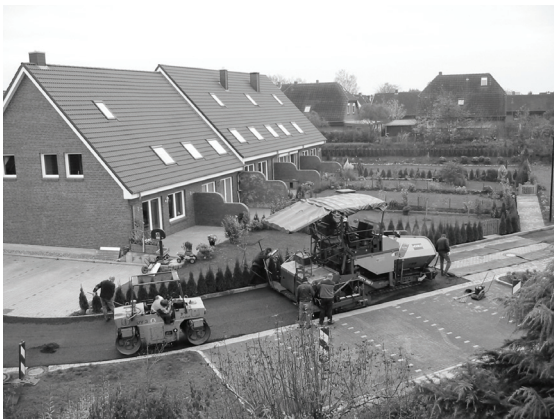
Jakob-Hinrichs-Weg 1-9, am 11.11.04 Fertigstellung der Straßendecke
