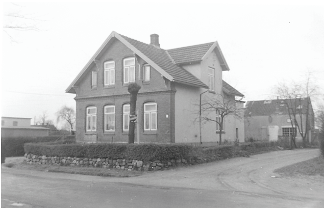
Haus Brügger Chaussee 8 Aufnahme 1954 Haus des Schusters Ernst Lentfer ab 1951, Gebäude rechts im Hintergrund war die Werkstatt
