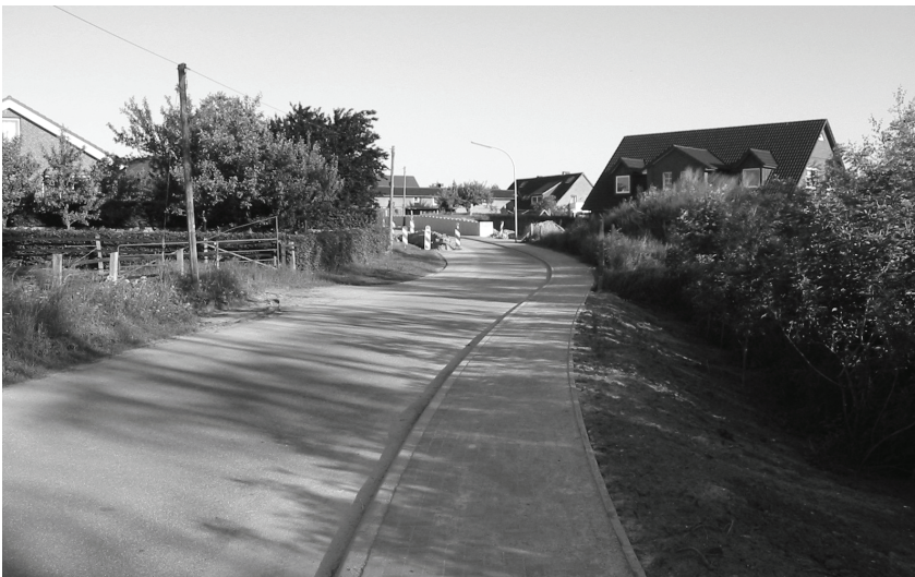
Buchwalder Weg mit neuem Bürgersteig und Baustelle zur Erneuerung der Wasserleitung
