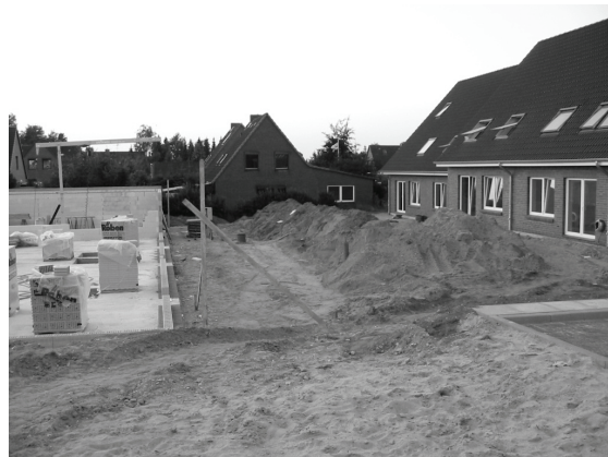
Baubeginn Jakob-Hinrichs-Weg 4a-e am 7.8.04
