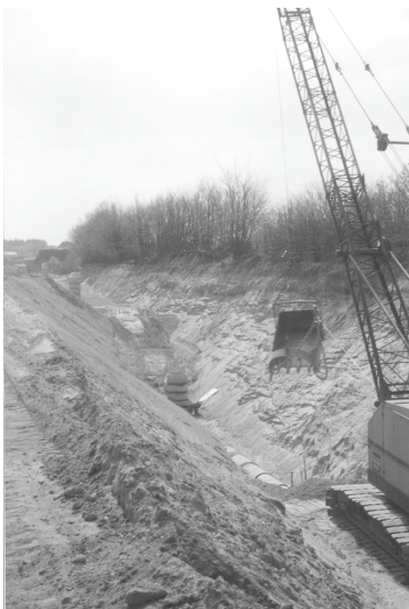
Kanalisation in Höhe des Orts- zentrums, Aufnahme Mai 1981
