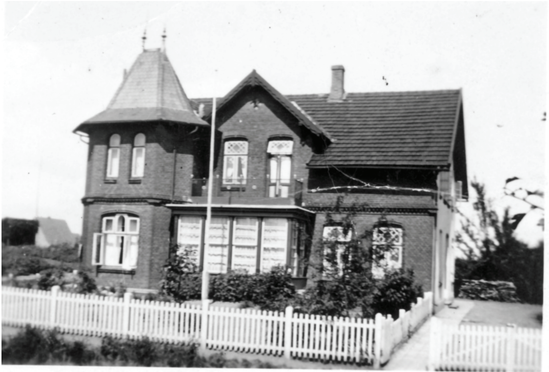
Brügger Chaussee 60, Baujahr 1906, Aufnahme ca. 1930
