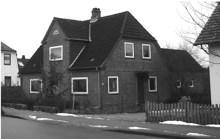
Abb. 8: Bahnhofstr. 4, Bauherr Paul Krützfeldt, später Bürgermeister von 1948 –1962
