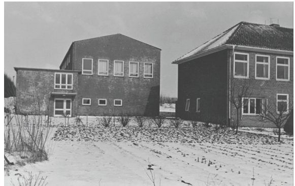
Links Turnhalle, rechts Schulgebäude, Blick von Süden, aus Richtung Schmiedekoppel
