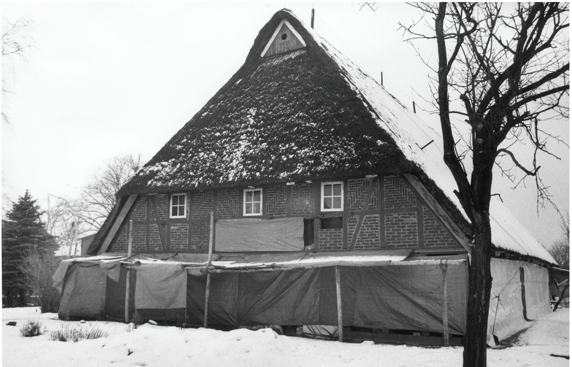
Die RäucherKate im Besitz der Gemeinde Wattenbek (1995) Beginn der Sanierungsarbeiten: September 1998, Aufnahme November 1998
